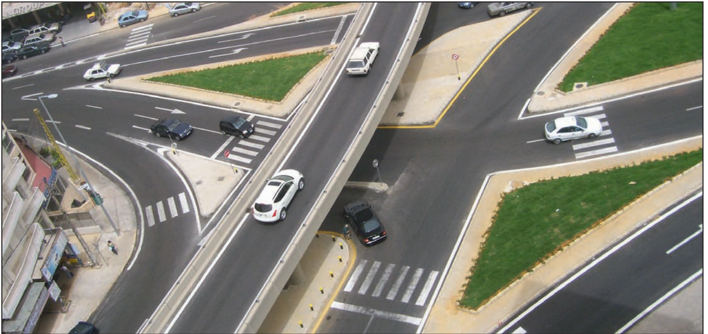
El Hayek interchange.
